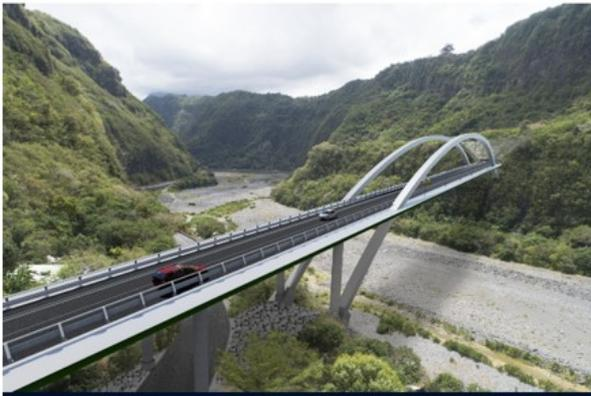
Pas de pile en rivière / hauteur de l'arc (15 mètres au dessus du tablier) / Coût prévisionnel : 14,8M€
