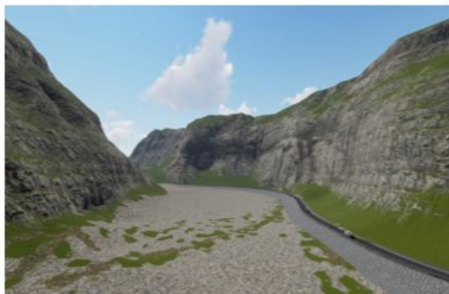
Réduction de la largeur du Bras de Cilaos / Protections importantes contre les risques d'affouillements et de protections en falaise contre les chutes de blocs / Fort besoin en matériaux / Coût prévisionnel : 17 à 21 M€
