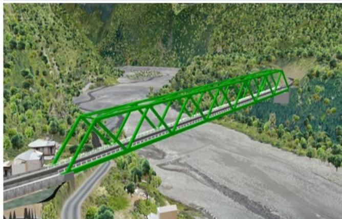
Structure massive nécessitant des moyens de levage importants pour réaliser des appuis provisoires en rivière, hauteur d'environ 15 mètres / Coût prévisionnel : 13,6M€
