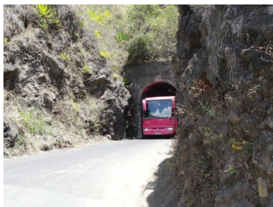
Bus traversant le tunnel de Cilaos
