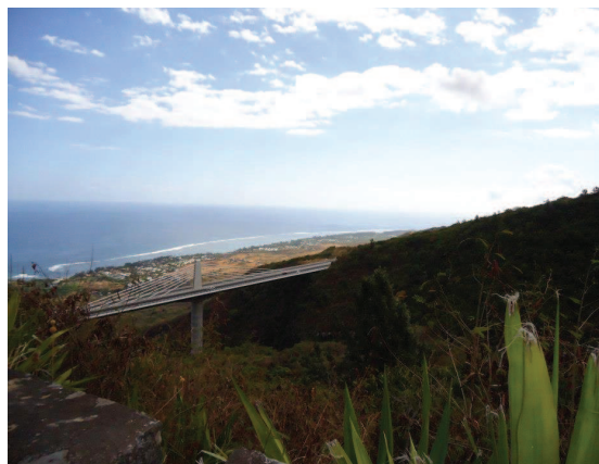
Ouvrage d'art inséré dans le milieu naturel (Exemple du viaduc de la Ravine de Trois-Bassins sur la Route des Tamarins)
