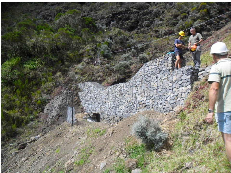
Figure 2 Seuil en gabions n°1 - Photo ONF 2019
