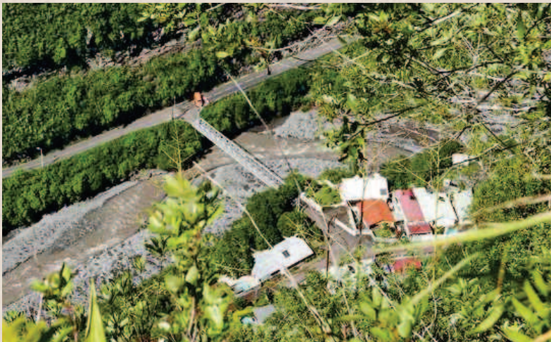
Passerelle au niveau de l'îlet Furcy
