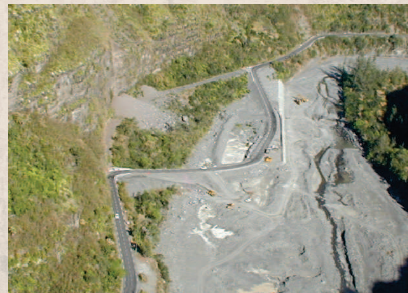
Evitement de l'éboulement au PR 8+300 (BRGM, Novembre 2002)
