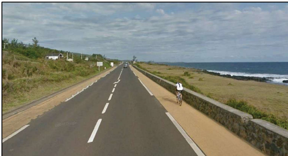
Figure 6 : VVR sur la N1A – Image Google Earth
