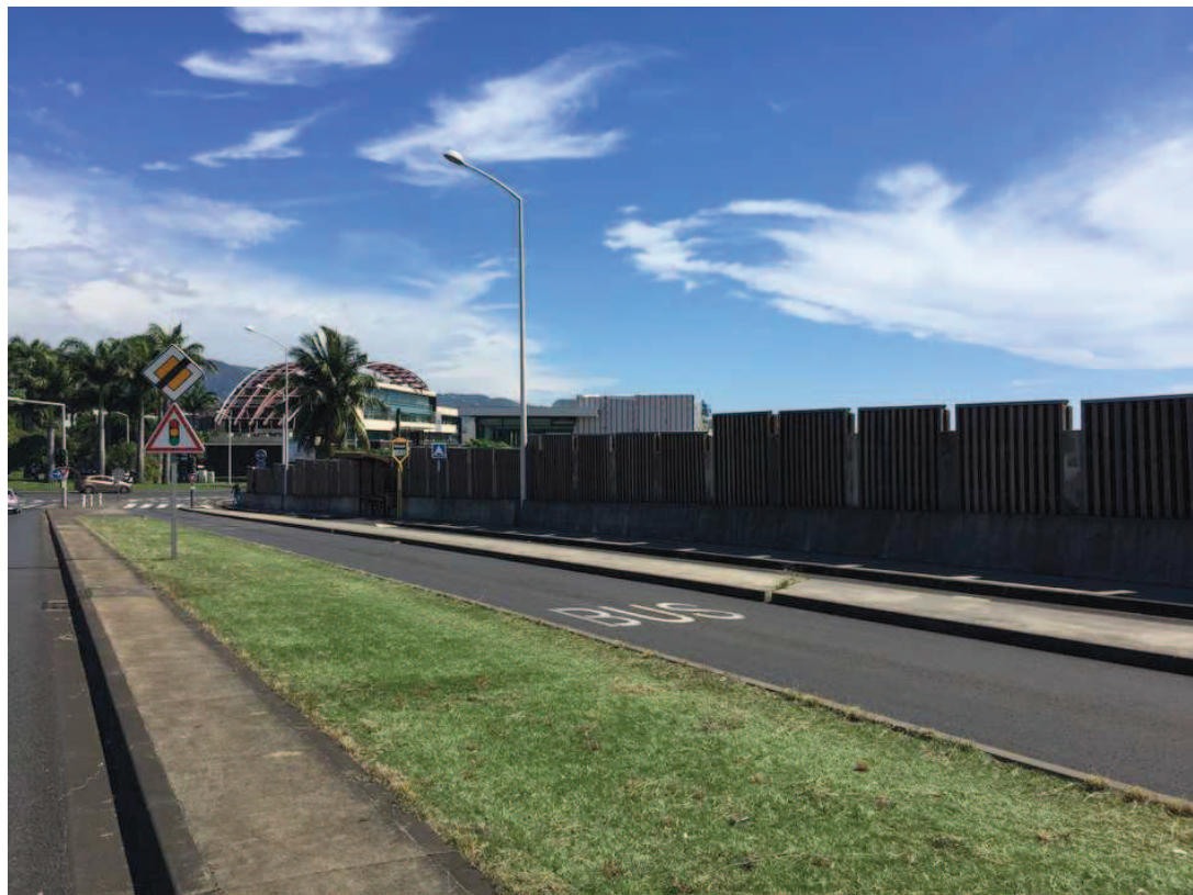
Illustration 5: Couloir Bus et voie cyclable, RN6
