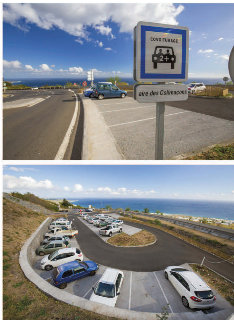
Illustration 3: Aire de covoiturage (Colimaçons), RN1
