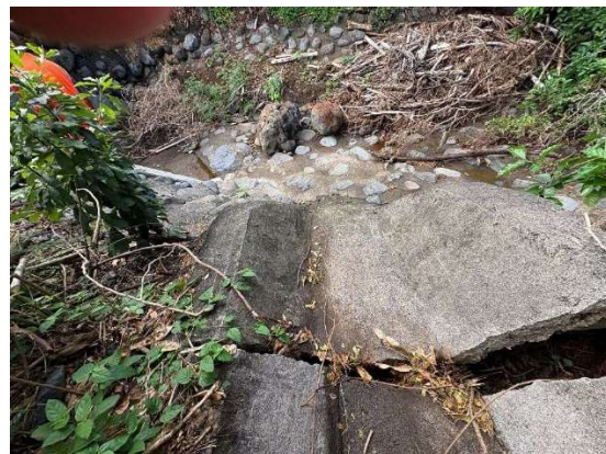
Situation avant travaux
