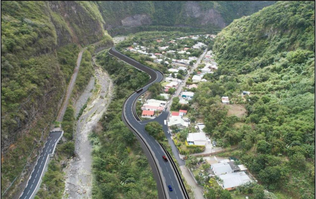
Route en remblai avec réduction de la largeur du Bras de Cilaos (sans impact sur le bâti)
