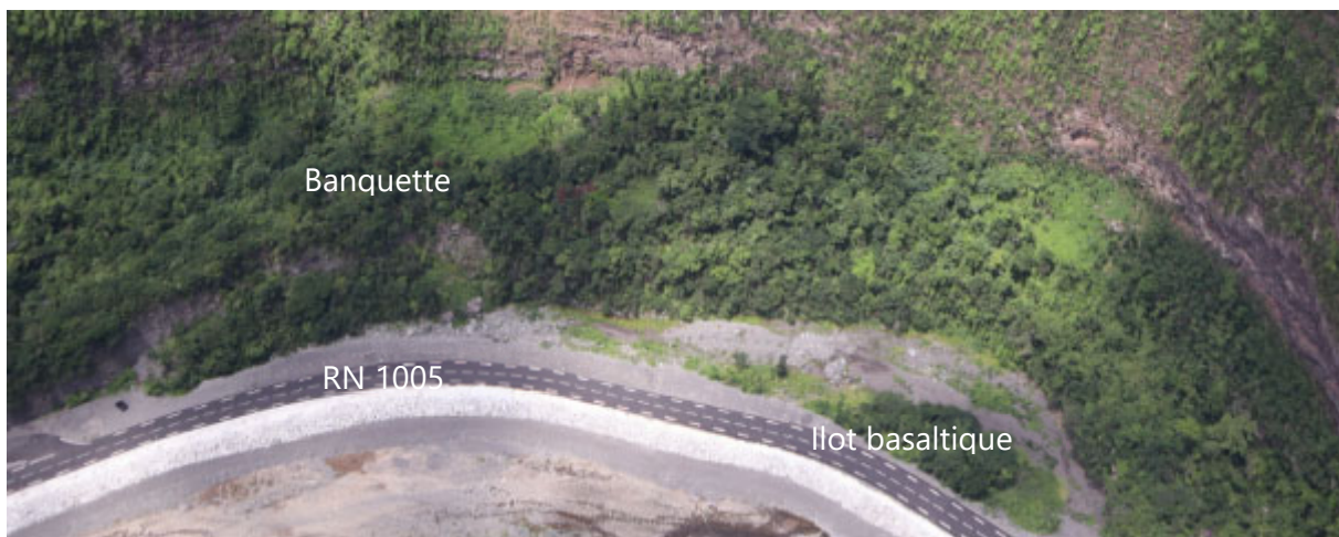
PHOTOGRAPHIE 20 : PIED DU REMPART EN RIVE GAUCHE D'ILET ROND
