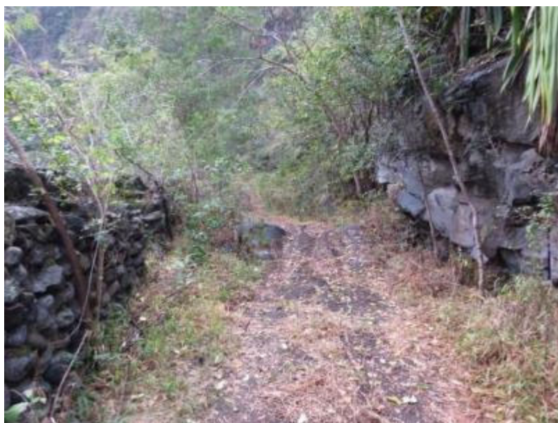
PHOTOGRAPHIE 12 : ANCIENNE RN5 FONDÉE DANS LES COULÉES BASALTiques EN PIED DE REMPART
