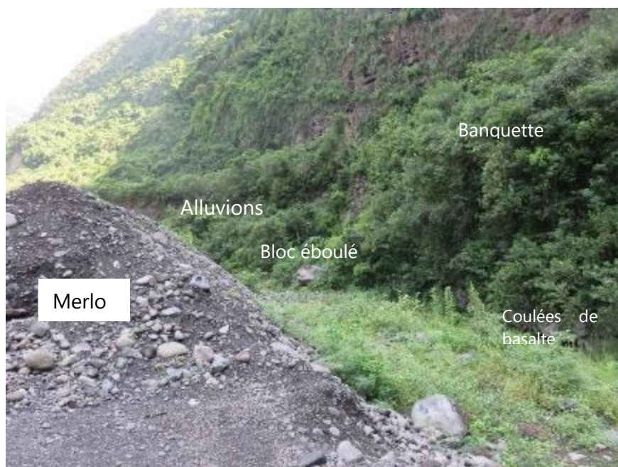
PHOTOGRAPHIE 21 : MERLON ÉRIGÉ EN AMONT DE LA RN 1005
