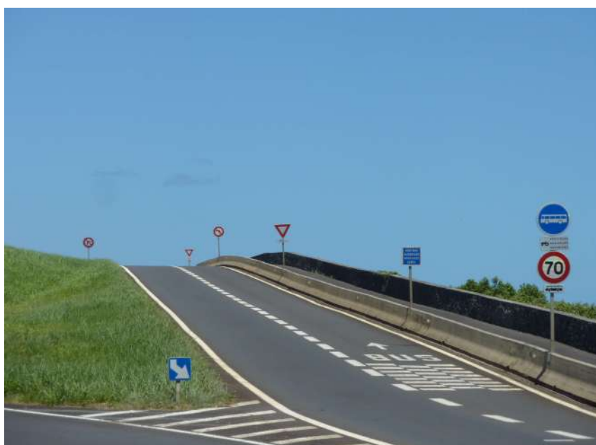
Illustration 2: Voie réservée aux transports collectifs et Voie Vélo Régionale à Sainte-Suzanne RN2
