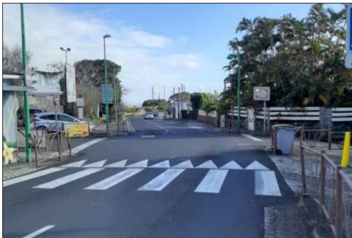
Illustration 4: limitation de vitesse à 30km/h, création d'un plateau traversant et suppression des pavés à Petit Saint-Pierre RN2
