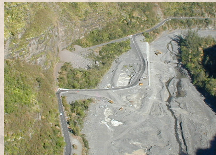
Évitement de l'éboulement au PR 8+300 (BRGM, Novembre 2002)
