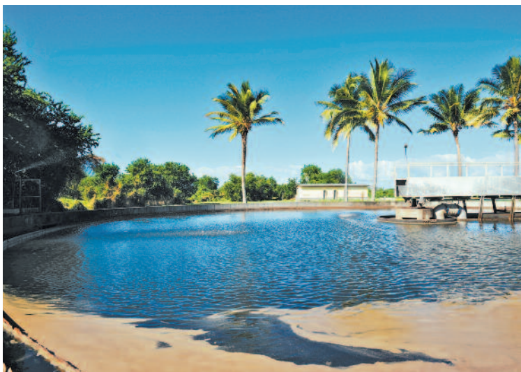
Une station d'épuration
